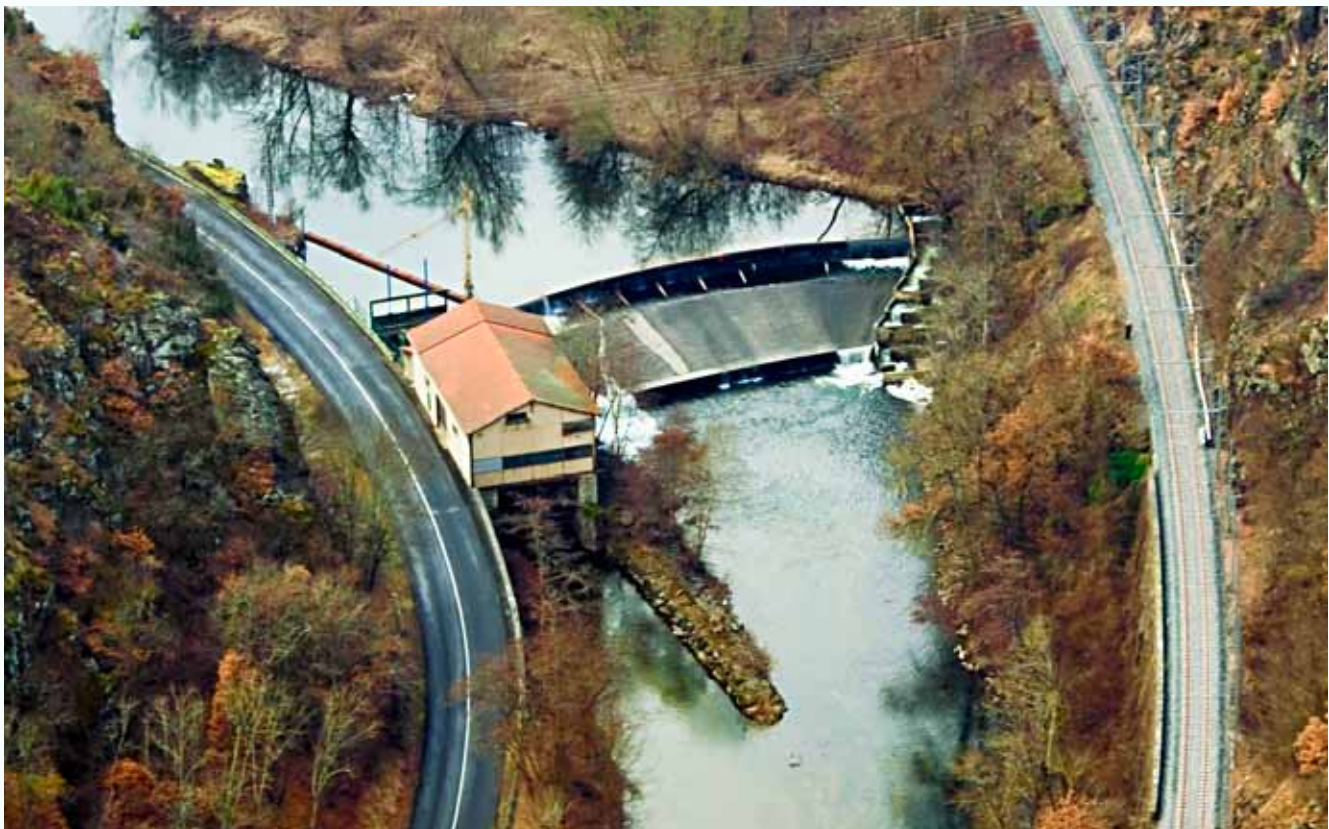
Kleinwasserkraftwerk in Lempdes-sur-Allagnon – Das erste Investitionsobjekt
