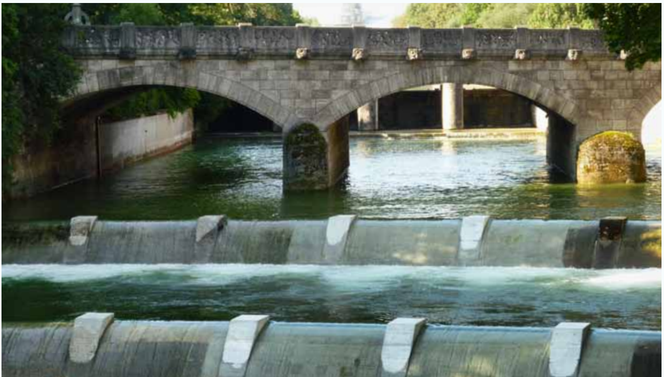
Flutung des Praterkraftwerks
