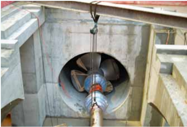
Einhub der Turbine in das Kraftwerkshaus im Februar 2010
