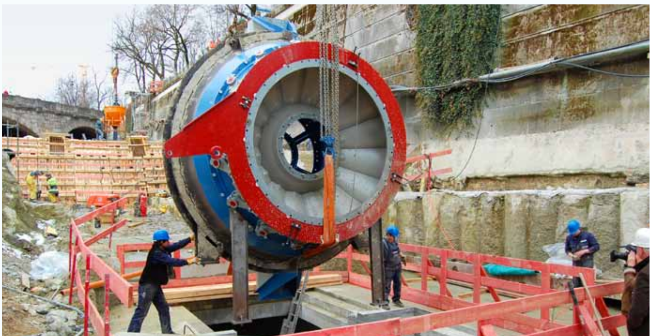
Februar 2010: Einhub der 30 Tonnen schweren Kaplan-Turbine ins Krafthaus des Praterkraftwerks München
