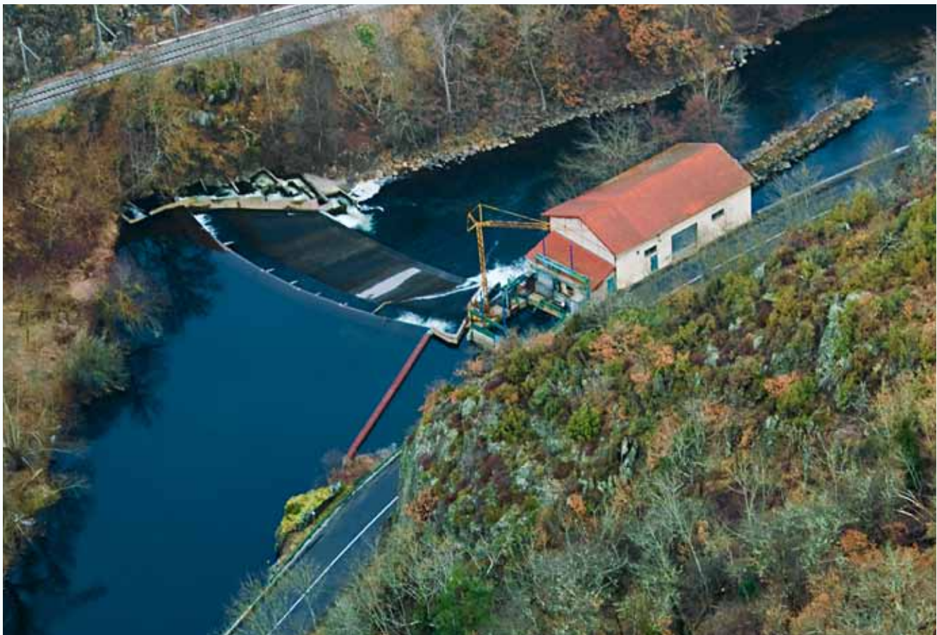
Das Kleinwasserkraftwerk in Lempdes-sur-Allagnon
