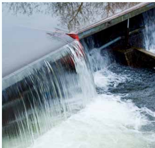
Wehr des Kraftwerks Lempdes
