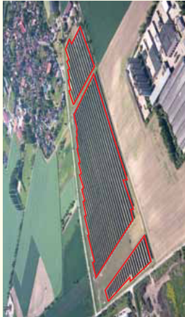
Die Luftaufnahme zeigt die drei Baufelder der Anlage. Die mit der PV-Anlage belegten Flächen sind rot umrandet.
