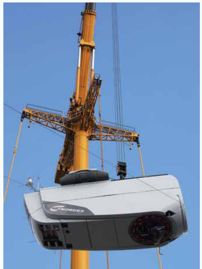
Nachdem der Turm fertiggestellt wurde, wird die rund 60 Tonnen schwere Gondel mit Schwerlastkränen zur Montage auf den Turm gehoben.
