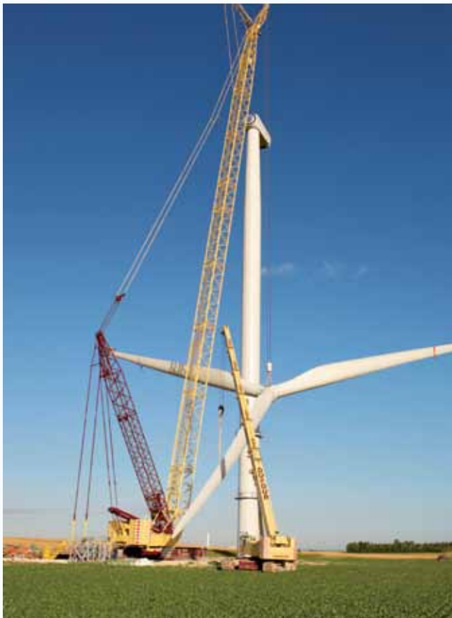
Die Rotorblätter werden am Boden mit der Rotornabe verschraubt und als so genannter Stern in einem Stück zur Gondel hochgezogen.
